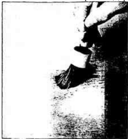
Рис. 58. Грунтовку наносят кистью или, как матовое покрытие, большим тампоном.
