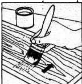
Рис. 63. Для равномерного распределения смеси можно использовать и кисть. Затем смесь втирают тампоном.
